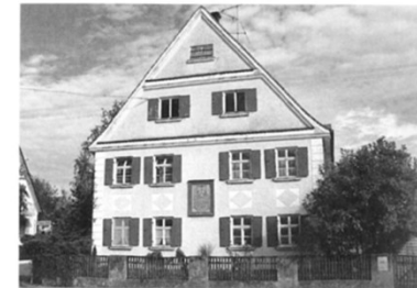
Auf der westlichen Giebelseite nennt eine Sandsteintafel das Erbauungsdatum 1781.
