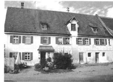
Südliche Traufseite des Wohnstallhauses mit Putzrustika und Rauten als Fassadendekoration.
