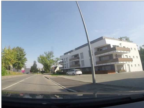
Herzog-Georg-Straße, Blickrichtung Norden (SP1)
