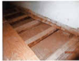
MITTELWAND NW BESTAND - UNTEN
