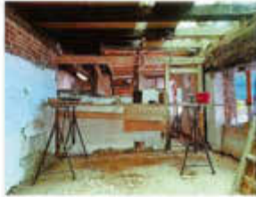
FACHWERKWAND NW 0001 SANIERUNG
