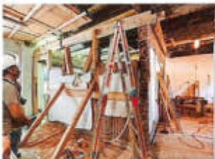
FACHWERKWAND NW 0001 SANIERUNG
