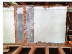
MITTELWAND NACH AUFLAGERSANIERUNG
