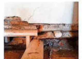
MITTELWAND NACH AUFLAGERSANIERUNG
