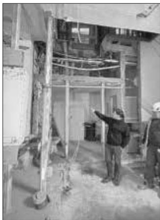
Die unerwartet hohe Schädigung der Tragkonstruktion in unzugänglichen Bereichen des Vortors und des Wehgangs verdeutlicht die bereits aus den intensiven Voruntersuchungen abgeleiteten dringenden Empfehlungen zur Sanierung des Torbereichs. Die damals erarbeiteten Empfehlungen und Notsicherungen trugen zu einer temporären Sicherung und Nutzung der
