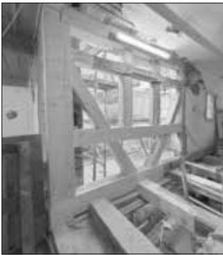
Die Dacheindeckung der Vortürme wurde bereits in der Sitzung vom 29.07.2024 behandelt und freigegeben. Durch das hohe Schadensmaß der Gesamtkonstruktion am Wehgang und der damit anschließenden Dachkonstruktion hat sich beim Rückbau gezeigt, dass die unsachgemäße Verlegung
