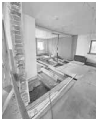
KRAY 1. OG BEGINNENDE DECKENBALKENSANIERUNG, ELT-VERKABELUNG
