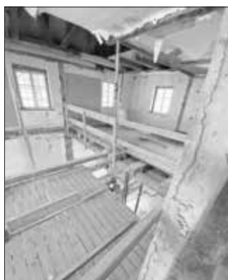
KRAY, ABRUCH FÜR KÜNFTIGE ERSCHLIESSUNG
