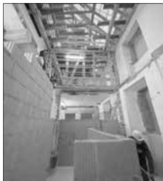
BLICK IM WOLL- UND WAAGHAUS, KÜNFTIGES TREPPENHAUS
