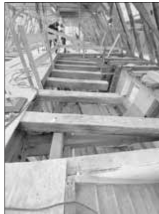
WOLL- UND WAAGHAUS, FREILEGUNG DES ERSCHLIESSUNGSBEREICHES IM DECKENBEREICH, BEGINN DER SANIERUNG DES DACHTRAGWERKS
