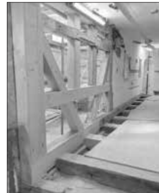
BEREICH DES VORTORS, TEILWEISE FACHWERKERSATZ UND VERSTÄRKUNG DES HAUPTTRAGWERKS, UNTER BEACHTUNG DER SICHERUNG DES HISTORISCHEN PUTZES
