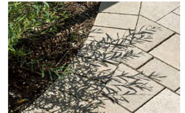
Abb. 31 Betonsteinpflaster mit offenen Fugen (Klimastein)
