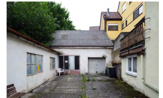
Hof mit ehemaligen Werkstätten, Hauptplatz 1
