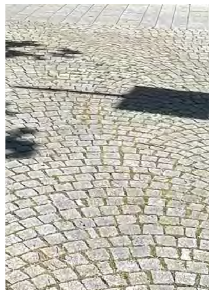
Abb. 38 Natursteinpflaster, offen verfugt
